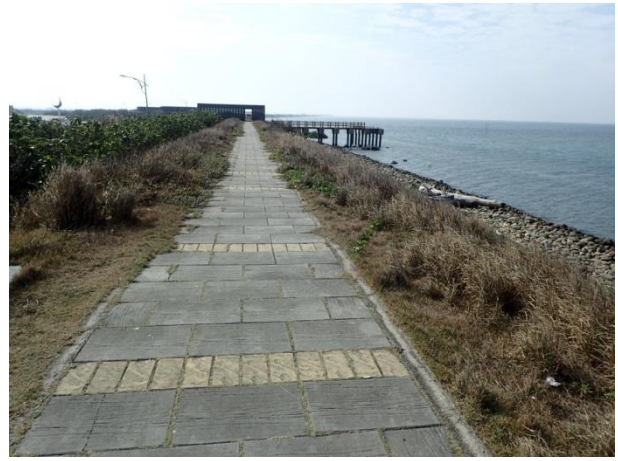
計畫範圍邊緣的堤岸環境現況
