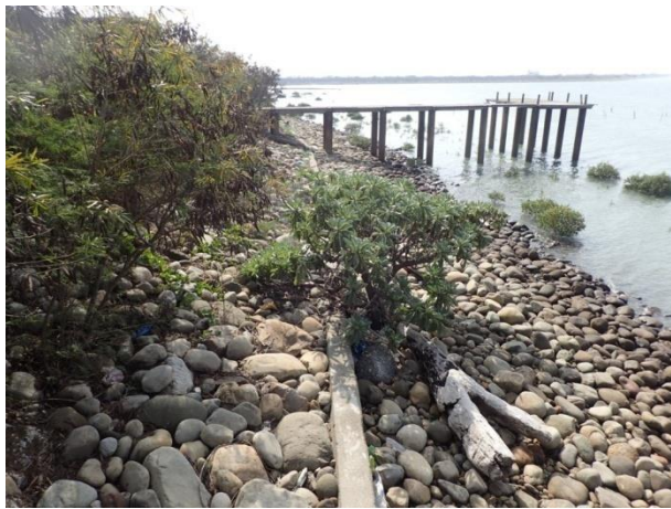
計畫範圍邊緣的防波堤及景觀步道平台現況
