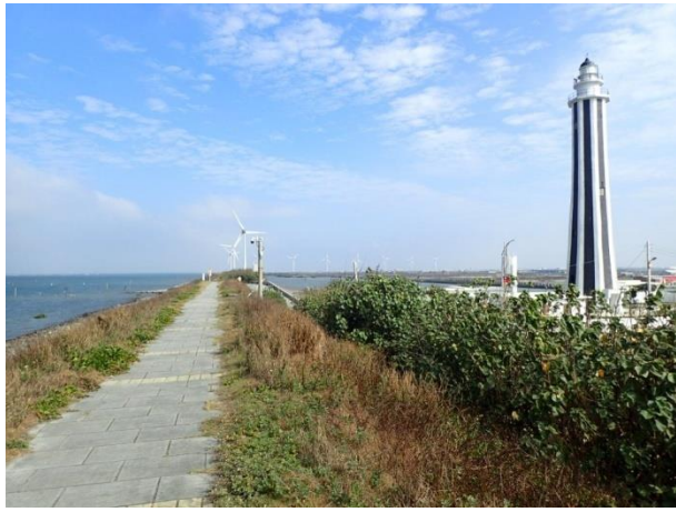
計畫範圍邊緣的堤岸環境現況
