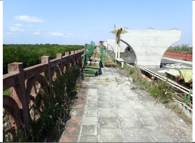
計畫範圍內的堤防設施及西濱道路施工現況
