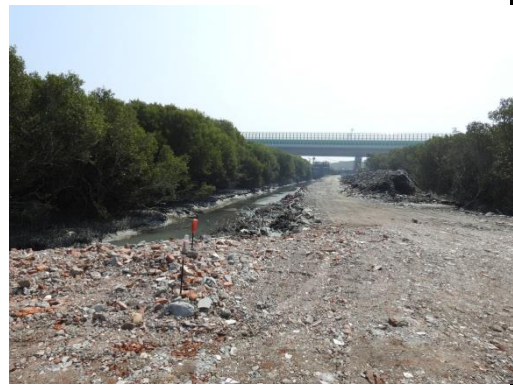
現地營建廢棄物進行夯實為施工便道之基底 109.3
