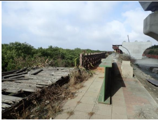
本計畫交界處之堤防設施及西濱道路施工現況
