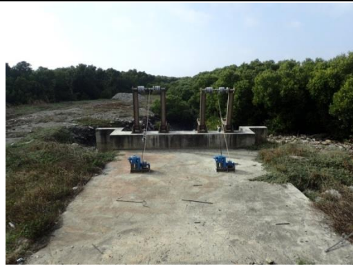
計畫範圍內的水閘門設施及紅樹林現況
