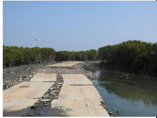
基地內環境(施工便道) 109.3
