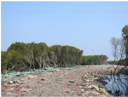
利用現地營建廢棄物進行夯實為施工便道之基底 109.3
