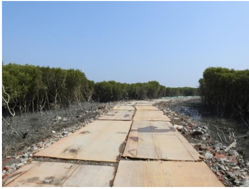
基地內環境(施工便道)109.3
