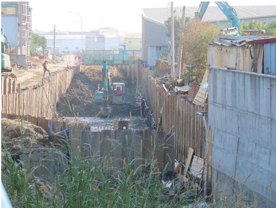
圖 4 花壇排水(第二期)上游改道工程現況圖(109.11.17 施工中)
