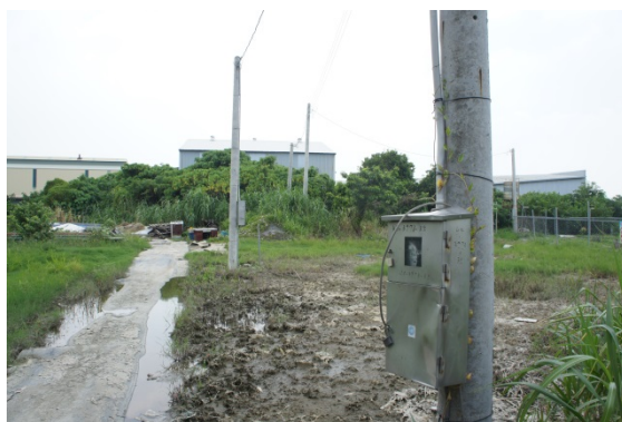
說明：排水路興建預定地
