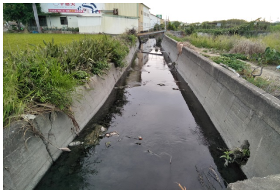
說明：花壇排水路現況
