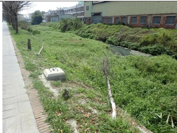
部分河道旁有景觀樹木乾枯未整理
