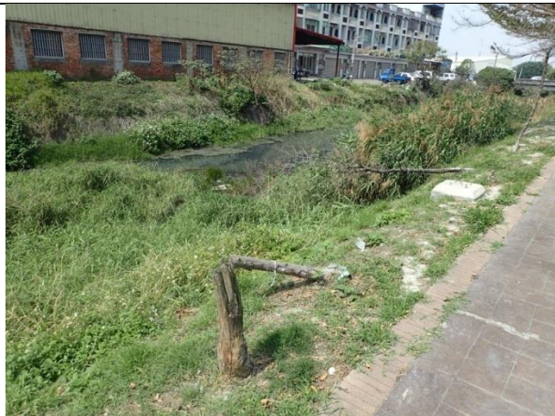
部分河道旁有景觀樹木乾枯未整理
